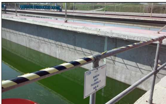
Reabilitarea bazinelor 3 si 4 de apa pluviala: reabilitarea pistelor de acces intre bazine, prevederea materialelor degivratoare, astuparea fisurilor.
