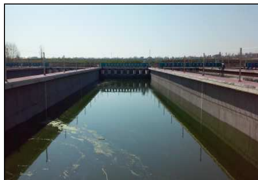
Reabilitarea bazinelor 3 si 4 de apa pluviala: reabilitarea pistelor de acces intre bazine, prevederea materialelor degivratoare, astuparea fisurilor.
